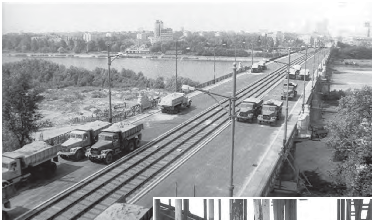
Pomiar odkształceń mostu Poniańskiego podczas próby obciążeniowej wykonany w czerwcu 1988 r.
