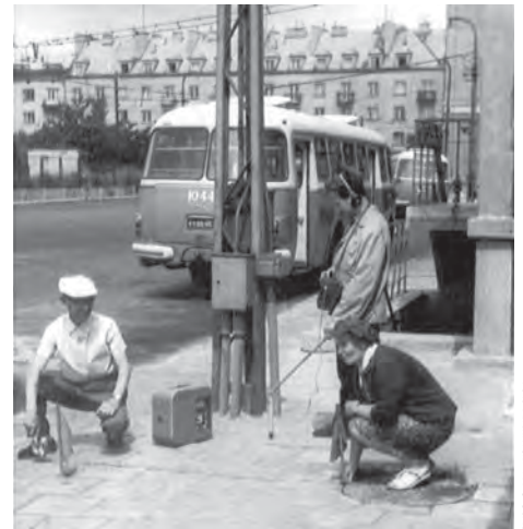
Wykrywanie urządzeń podziemnych, koniec lat 60. Z prawej – Maria Skatulska, jedna z niewielu kobiet pomiarowych w WPG
