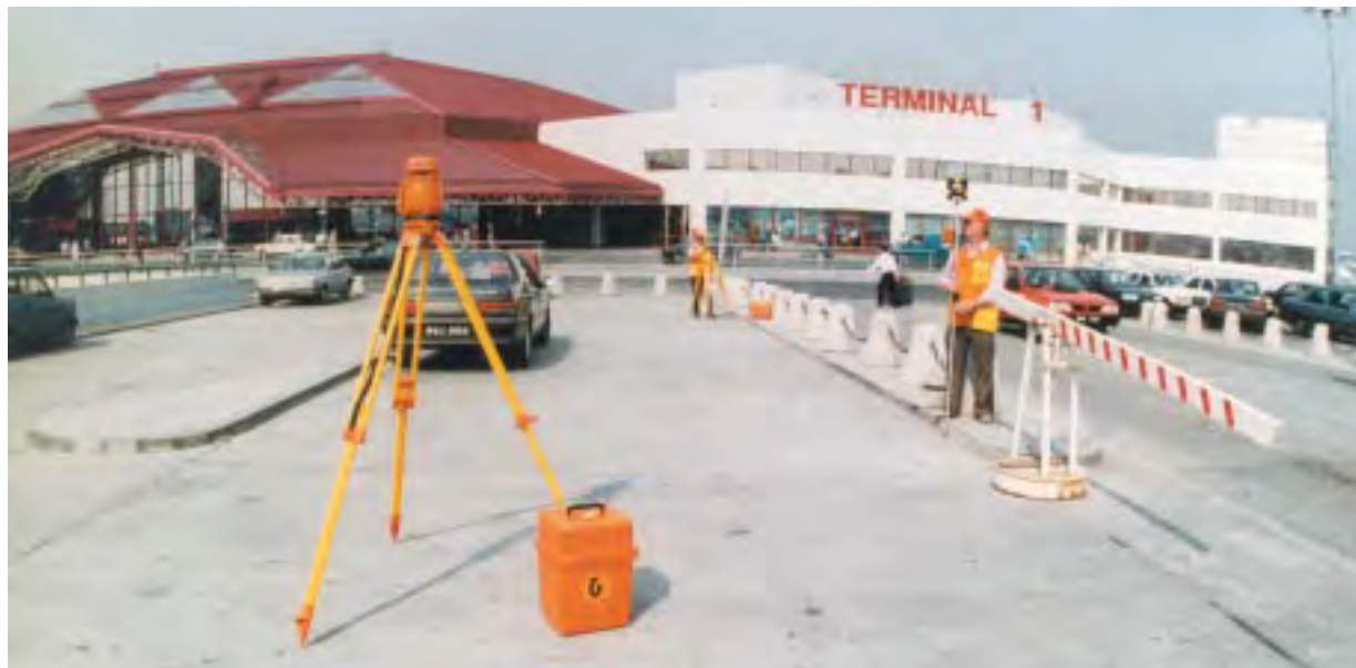
Na budowie terminalu Okęcie
