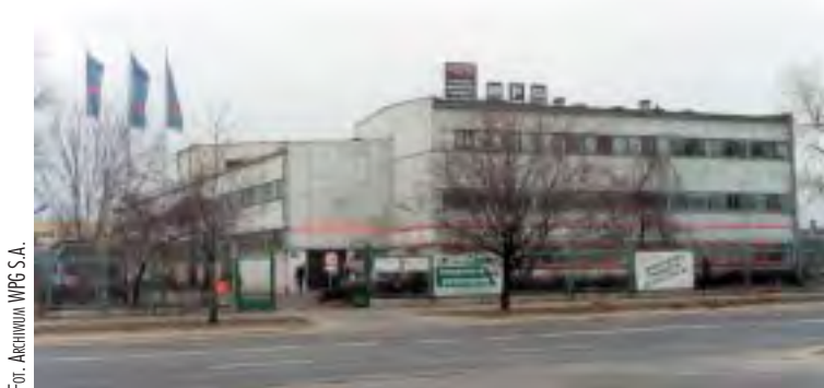
Budynek przy ul. Sokratesa 7
